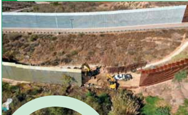
Il muro in costruzione al confine a Tijuana
